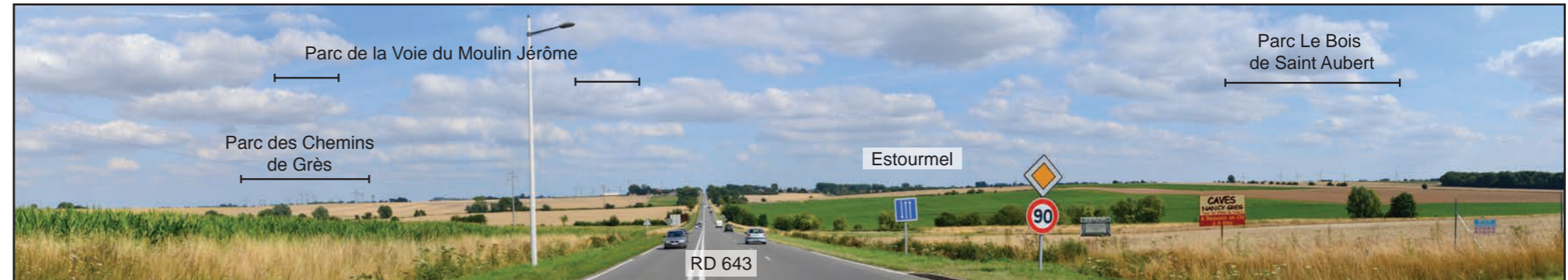
État initial - Vue panoramique
